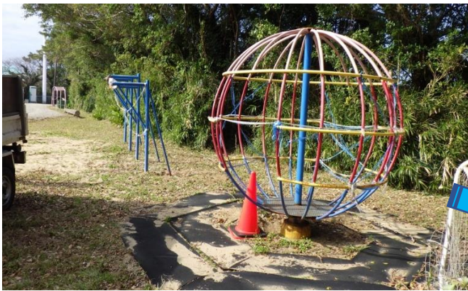
撤去作業前の回転遊具と鉄棒。
