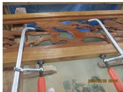
◎定住促進住宅 欄間修繕
