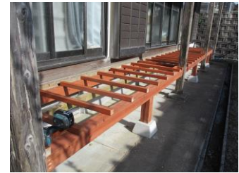
(施設営繕：住宅修繕状況)
