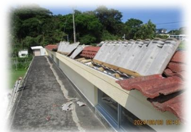
市営プールの屋根瓦を修繕
